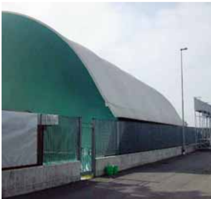
Presto i lavori al campo polivalente di Fara Olivana con Sola
