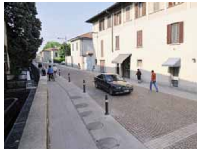
Terminati i lavori, via Cavallotti riaperta con le «correzioni» FOTO CESNI
