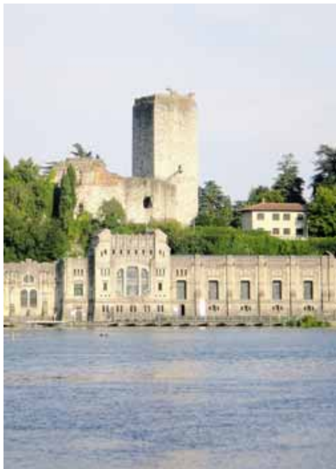
Partiranno a giugno i lavori di restauro della torre del castello di Trezzo
