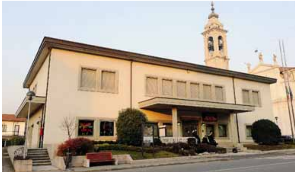
Il municipio di Gorlago: sull'edificio verrà installato un impianto fotovoltaico
